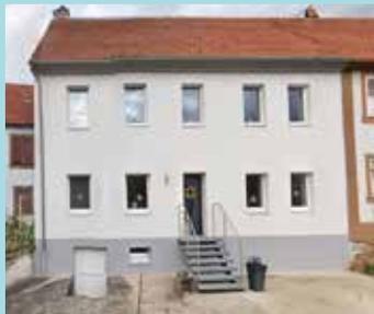
Après ITE, perte des encadrements, des linteaux en arc, des menuiseries et des volets
