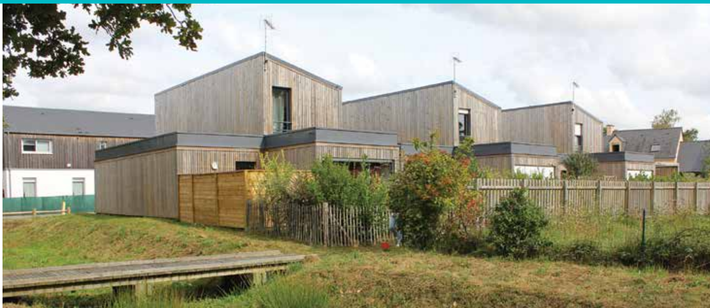
▲ Chapelle-des-Marais, Le Clos du Moulin (44), ARLAB architectes - Ensemble de 13 éco-maisons
