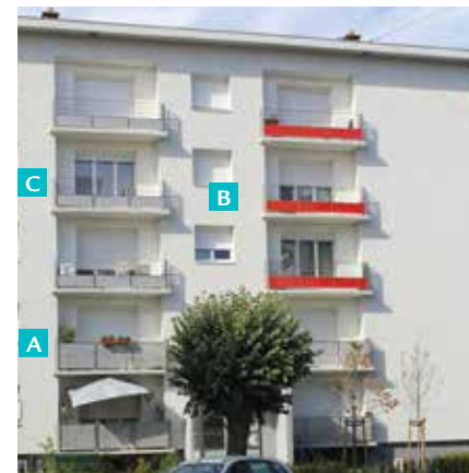
▲ Immeuble à Thionville. Les variantes d'écriture architecturale du balcon (repères A, B et C) montrent l'apport du soin apporté à la conception détail technique à l'esthétique d'ensemble.
