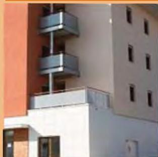
Système ITE avec isolant laine de roche et sous-enduit à la chaux aérienne.
