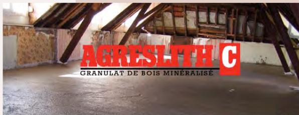
AGRESTA Technologies a développé un granulat spécifique pour la réalisation de bétons légers, isolant et écologiques. Remplacer les graviers par des granulats de bois stabilisés dans les mélanges à béton permet d'apporter des caractéristiques bien particulières telles que légèreté, isolation et propriétés écologiques.
