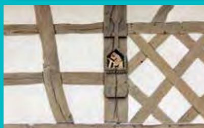
Pan de bois : colombage avec son remplissage de torchis et l'enduit protecteur au mortier de chaux.
