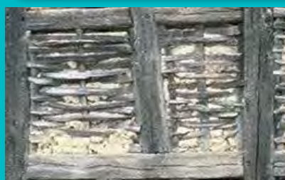
Détail d'une structure "à colombage", avec son remplissage, clayonnage de bois garni de torchis, c'est-à-dire argile mêlée de paille hachée.
